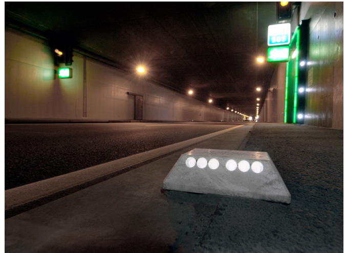
Tunnel St. Maurice, Valais
