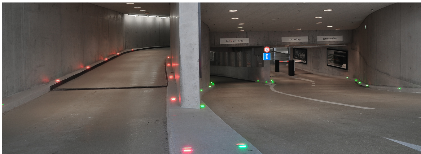
Systèmes de guidage LED dans le parking de la Haute Ecole FHS de Saint-Gall.
