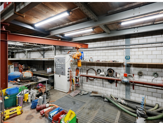
BetaLUXX Arbeitsplatzbeleuchtung Implemia Oberentfelden
