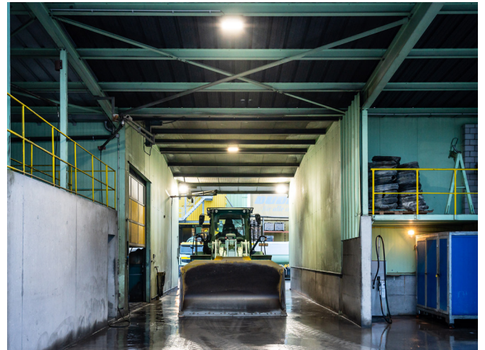
Éclairage avec AlphaLUX
