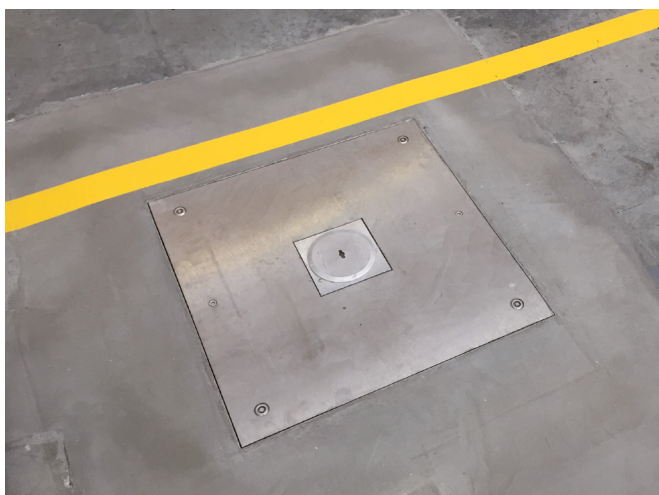
Exemple sol en béton
