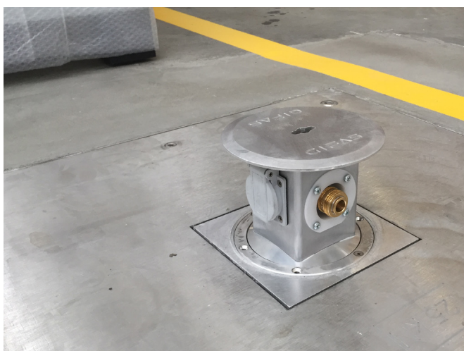
Exemple sol en béton
