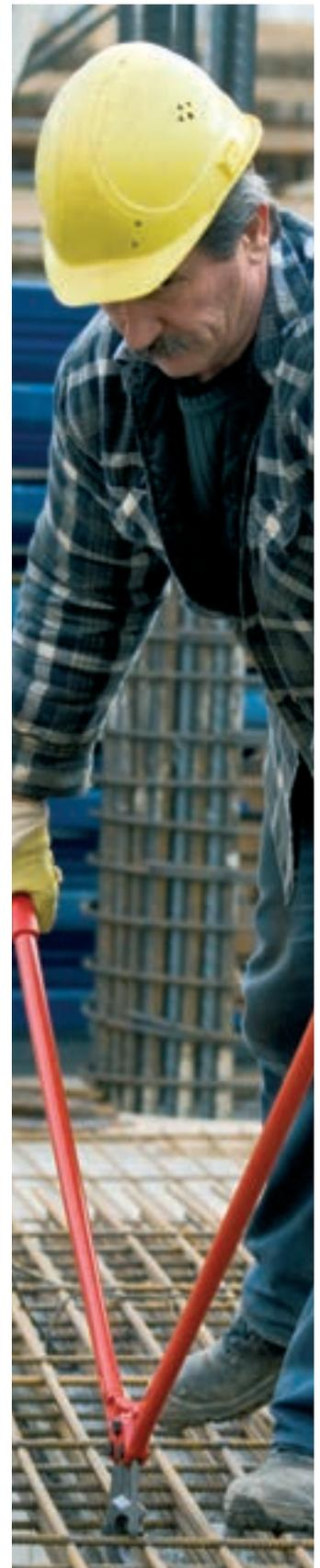
Die besondere Kopfform des Mattenschneiders 71 82 950 ermöglicht das Schneiden flachliegender Baustähle
